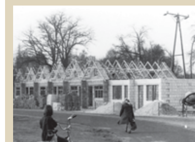
Budowa pawilonów na ul. św. Kazimierza
