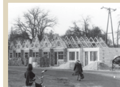
Budowa pawilonów na ul. św. Kazimierza
